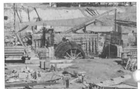
Einbau des Absaugrohres
